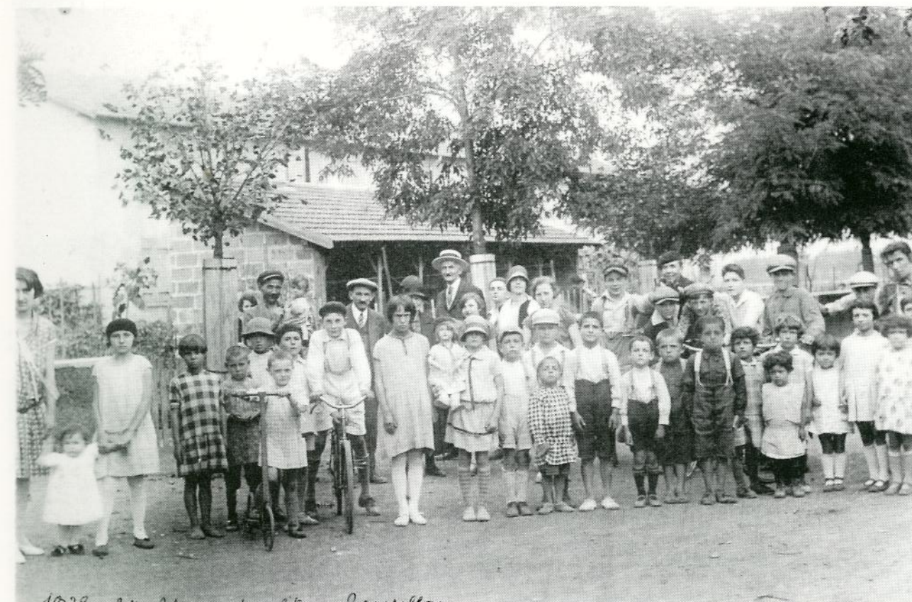
23 - 1928, les cités, 3 e avenue, on pose...
