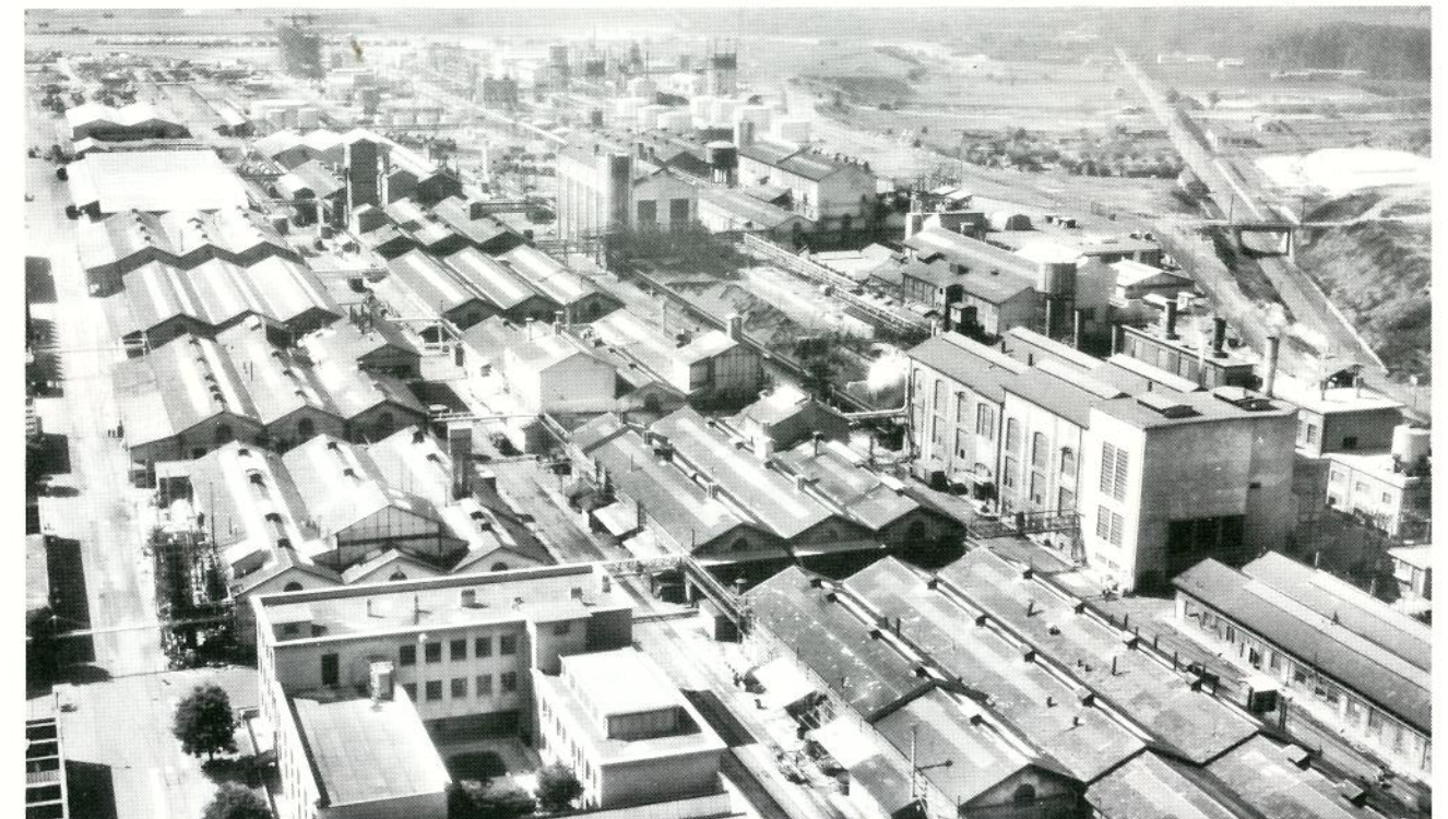
39 - 1960, l'usine Rhône-Poulenc vue du nord. Dans le parc à combustible la sphère de gaz de Lacq voisine avec les tas de charbon. Les laboratoires et le secteur du "Synthétique" sont terminés, la toute nouvelle tranche 3 du phénol se devine dans le lointain.
