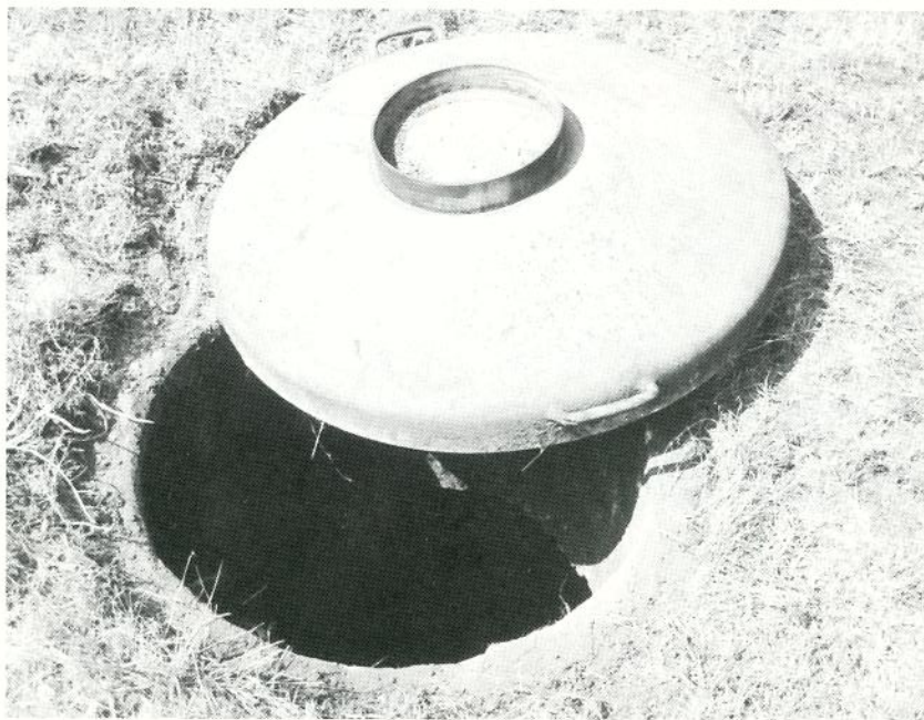
29 - L'issue de secours d'un abri enterré et son couvercle pivotant.
