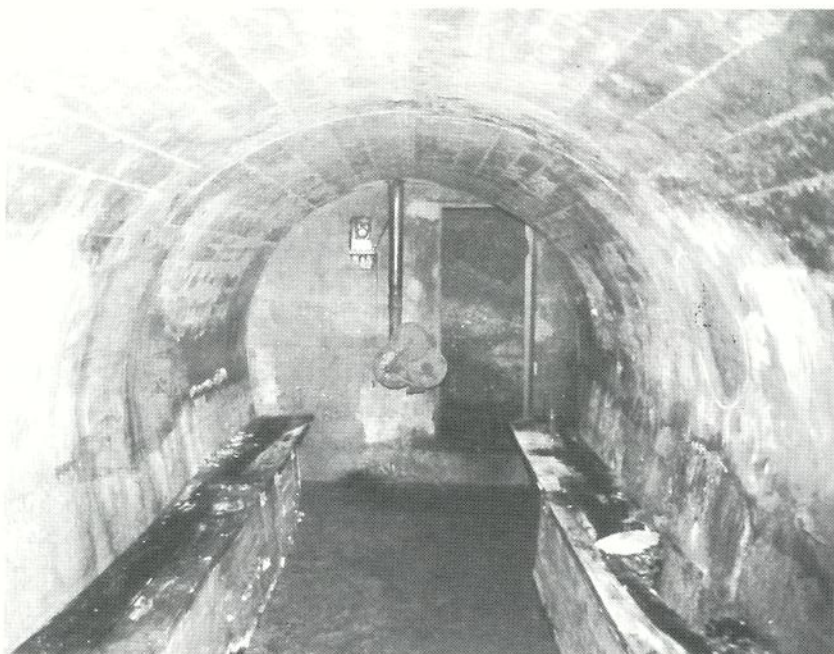
30 - Intérieur d'un abri. Au fond, à droite, l'entrée principale, à gauche le ventilateur d'aération. Le puits de l'issue de secours, équipé d'une échelle, se trouve côté opposé.
