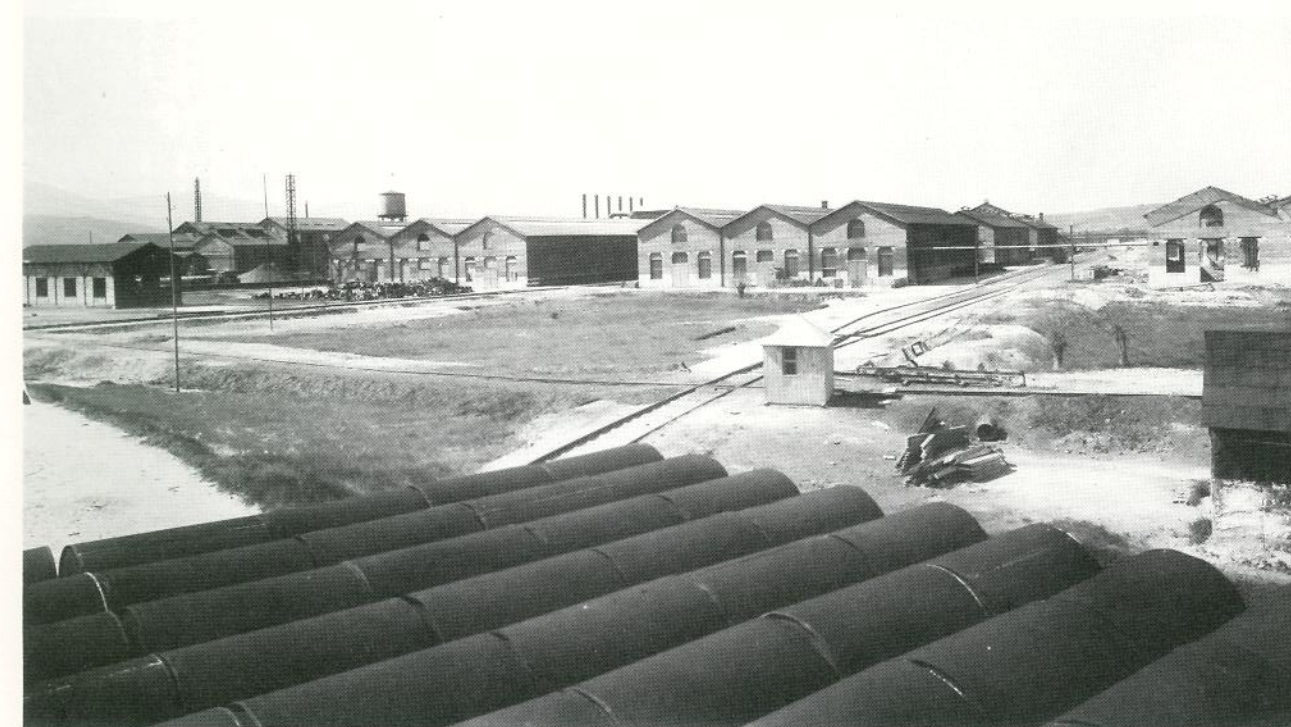
14 - 1919-20, l'usine déserte vue du sud.
