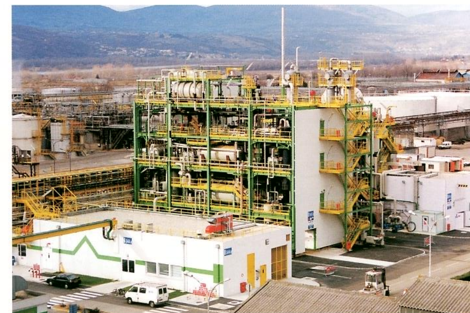
44 - Rachel, installation récupérant un sous-produit des M.C.S. pour fabriquer du chlorure de méthyle destiné aux M.C.S...
