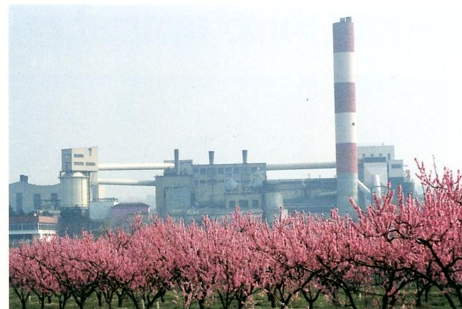
43 - L'ensemble de la chaufferie. De gauche à droite : les silos à charbon, les anciennes chaudières (charbon, gaz, fuel), la cheminée de 80 m et la nouvelle chaudière charbon, les conduits aériens des convoyeurs à combustible et scories... et les pêchers en fleurs !
