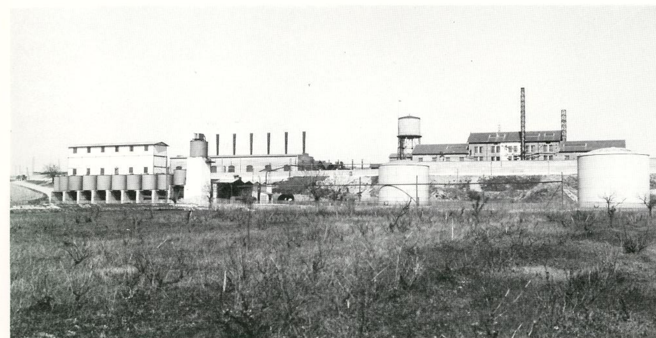
13 - 1919-20, l'usine déserte. De gauche à droite, la benzine, la chaufferie sans fumées, l'ypérite.
